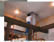
5m高所設置エアコン洗浄中
